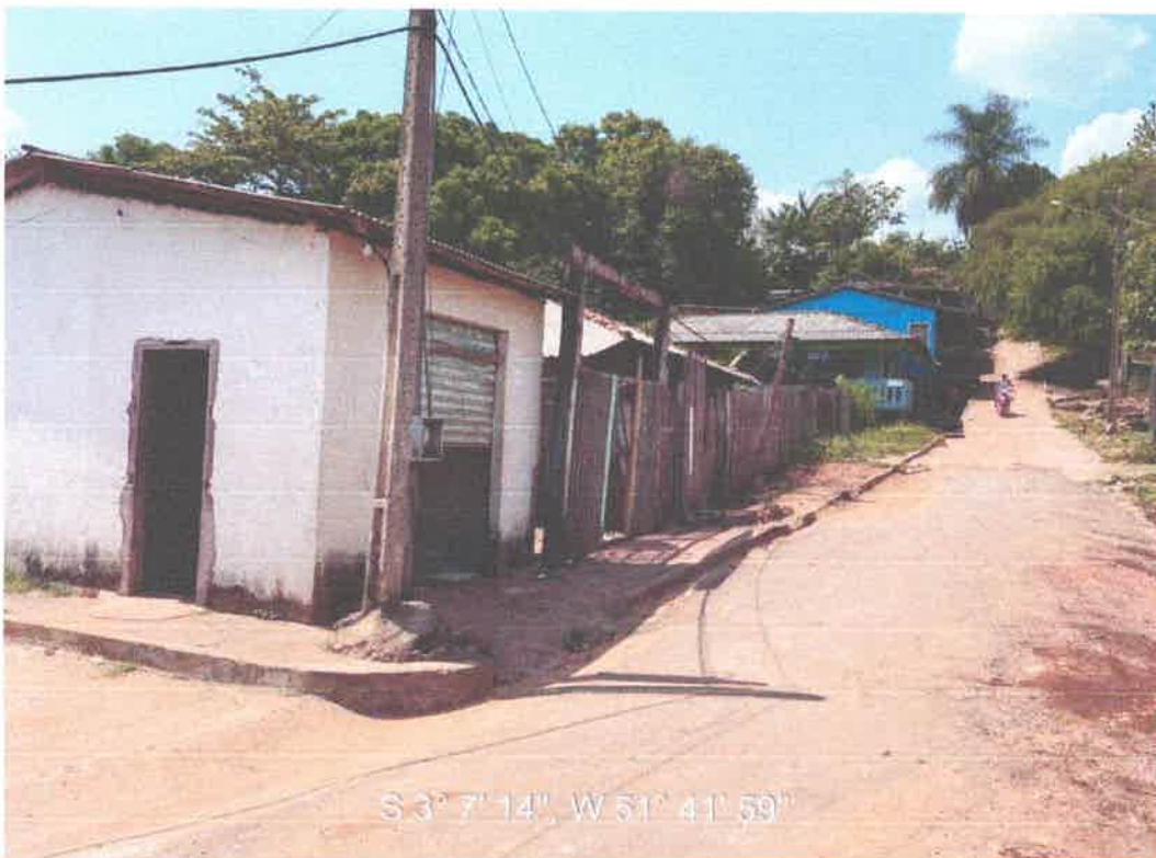
FOTO 3 - VISTA EXTERNA - ACESSO RUA
