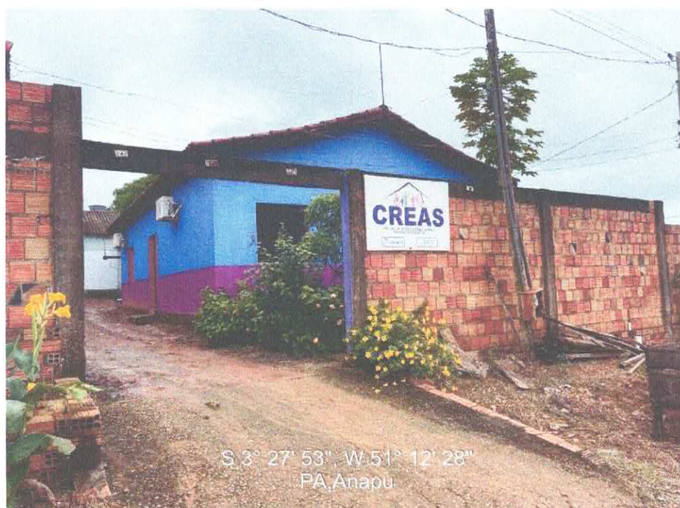
Imagem 03 - MURO E PORTÃO DE ENTRADA
