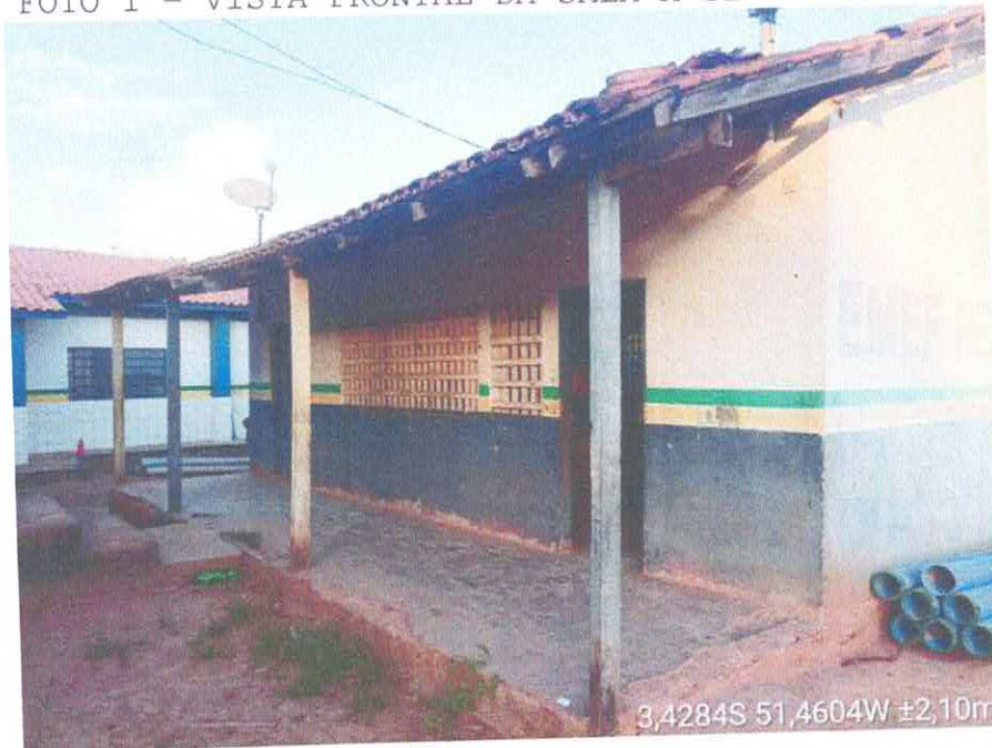
FOTO 1 – VISTA FRONTAL DA SALA A SER REFORMADA
